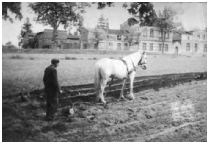
Prace polowe. Na drugim planie wąbrzeskie kamienice przy ul. Grudziądzkiej
