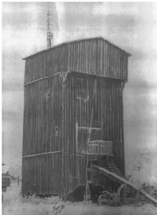
Pierwotna konstrukcja wiatraka, fot. z 1973 r.
