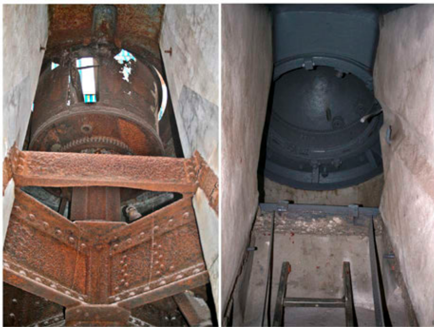
Ryc. 6. Fort 44 Tonia. A. Fragment wieży wysuwalno-obrotowej w trakcie konserwacji; B. Kopuła wieży obserwacyjnej, po konserwacji. Fot. H. Rojkowska-Tasak
