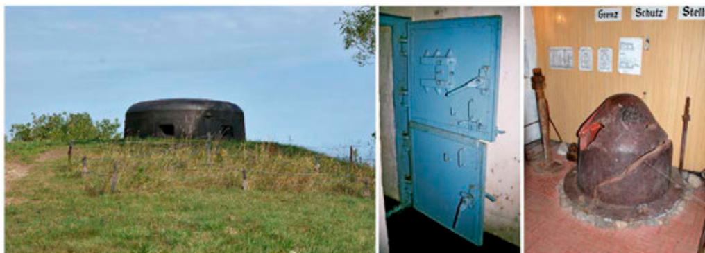
Ryc. 3. Schron 113d w Bakalarzewie: A – Kopuła 20P7; B – drzwi ciężkie typu 434PO1; C – ekspozycja w schronie. Fot. Adam Żywicznyński.
