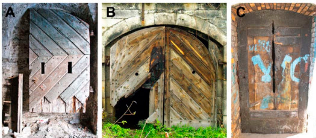
Fot. 3. A. Nysa, Reduta Kardynalska, Prawe skrzydło wrót (1744 r.). Krytyczny stan zachowania najstarszych wrót fortecznych na Śląsku. W 1997 r. wrota zostały porwane przez powódź tysiąclecia, co spowodowało korozję biologiczną zwłaszcza w dolnej części wrót. Zawieszone z powrotem przez wolontariuszy Akademii Przygody. Obecnie przeniesione do magazynów spółki komunalnej; B. Kłodzko, Twierdza Główna, Nowa Poterna Wysokiego Redanu, wrota dwuskrzydłowe (poł. XIX w.), zamontowane wtórnice, podpalone w ostatniej dekadzie. Obecnie przeniesione do okresowo silnie zawilgacanej kazamaty; C. Kłodzko, Blokhauz kolejowy, drzwi dębowe (1879 r.), stan po podpaleniu. Drzwi silnie porażone przez szkodniki techniczne drewna. Fot. G. Basiński 2011.
