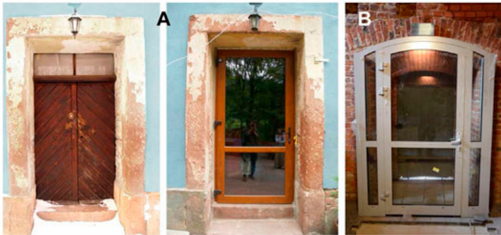
Fot. 4. A. Srebrna Góra, Koszary podłużne, drzwi dwuskrzydłowe z nadświetlem (1776 r.), widok przed i po montażu dodatkowego zamknięcia. B. Srebrna Góra, Donżon, wiatrołap drzwi wejściowych do kazamaty oficerów. Fot. G. Basiński 2011-2012.
