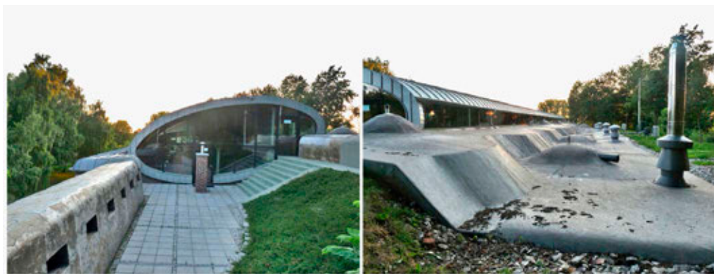
Ryc. II. Ingerencja architektoniczna w unikatowy w skali europy fort pancerny 47a „Węgrzce”, wynikająca z niezrozumienia podstawowych cech zabytku: A – manierystyczna i pretensjonalna forma nadbudowy, przecięcie oryginalnego przedpiersia, B – zakłócenie sylwetki fortu poprzez jej podniesienie. Fot. J. Środulska-Wielgus.
