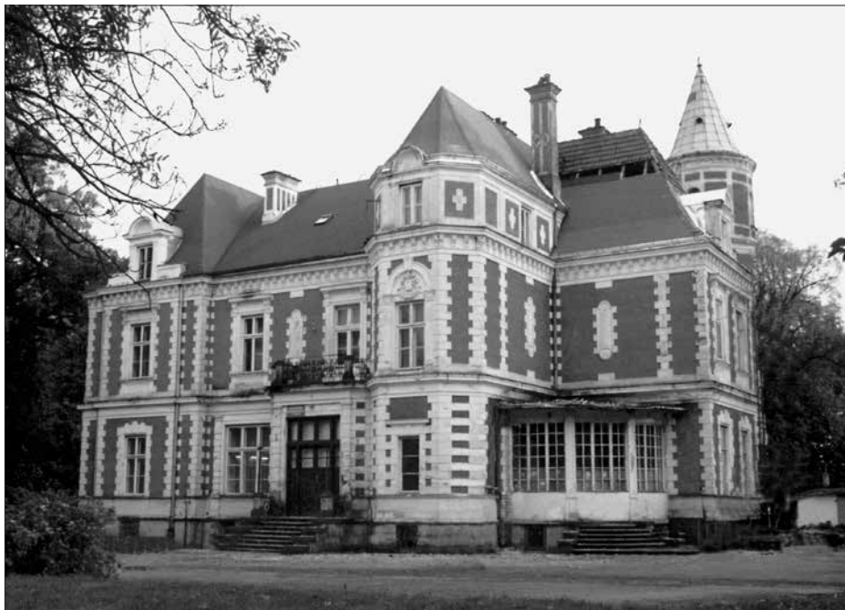
Fot. VII.1. Brzezie – pałac, elewacja frontowa w ujęciu od strony północno-zachodniej, 1999 r.
