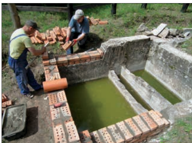
Fot. X.18. Prace rekonstrukcyjne – kopalnia „Montania”, 2011 r.
