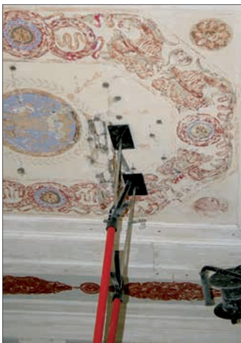
Fot. XV.13. Pałac Biskupi we Wrocławku. Jadalnia w trakcie prac konserwatorsko-restauratorskich. Podklejanie pęcherzy i rozspojen tynku.
