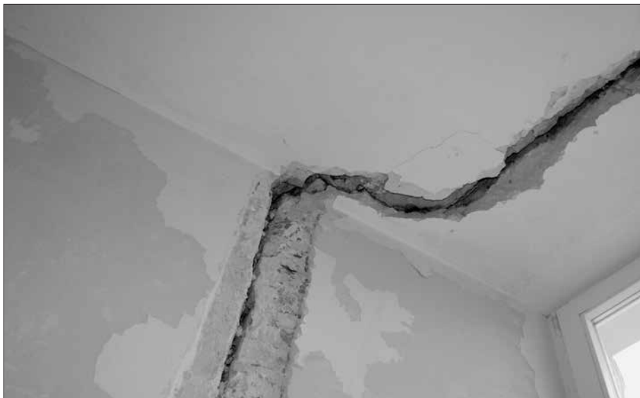
Fot. XV.2. Pałac Biskupi we Włocławku. Salon przed pracami konserwatorsko-restauratorskimi. Naprawy murarskie – naprawa więźań ścian i stropów.
