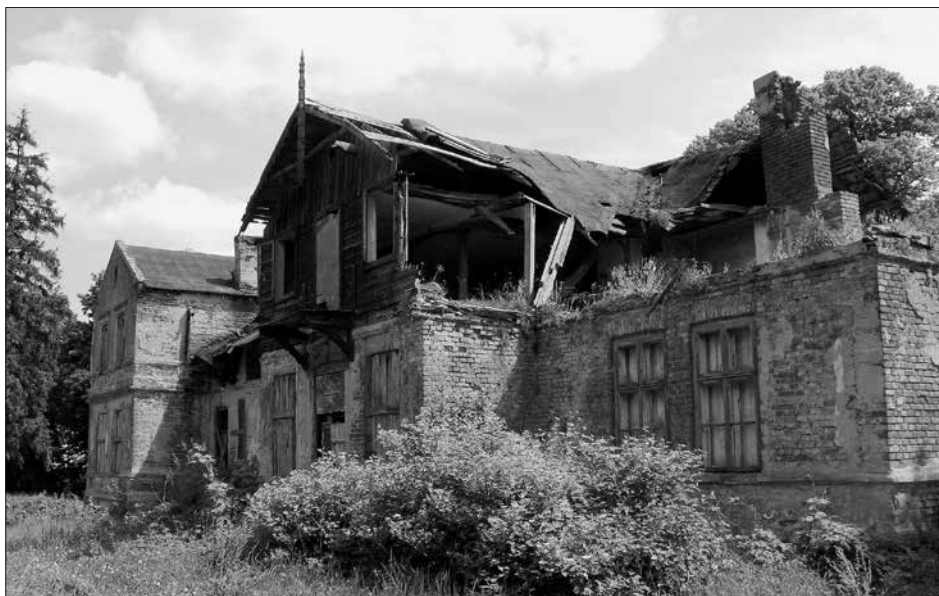
Fot. XVIII.2. Widok dworu w Kłóbce, 2010 r.
