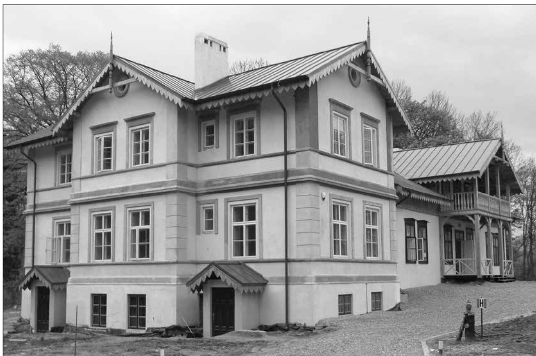
Fot. XVIII.4. Widok dworu w Kłóbce, 2014 r.
