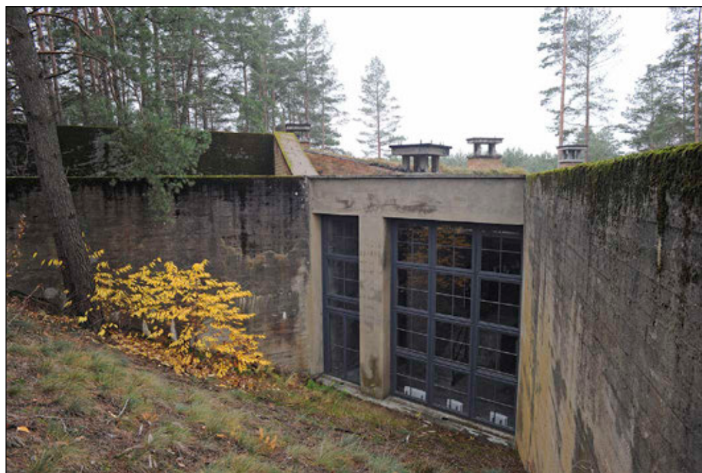
8. Budynek 1141 – Budynek stabilizacji nitrogliceryny
