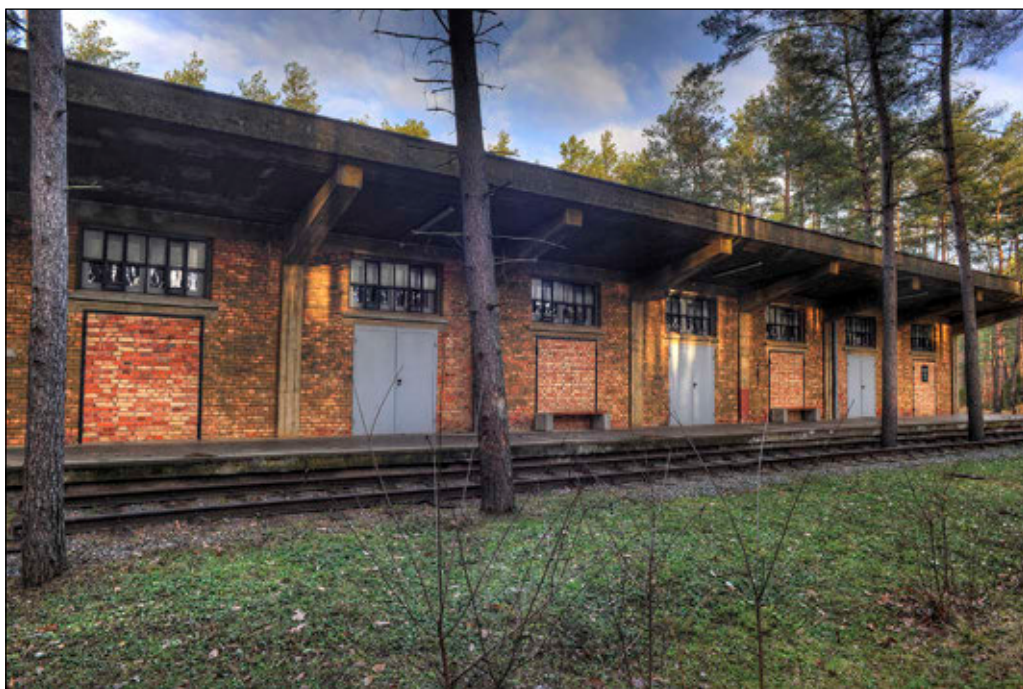
10. Budynek 1157 – Budynek walcowania i magazynów
