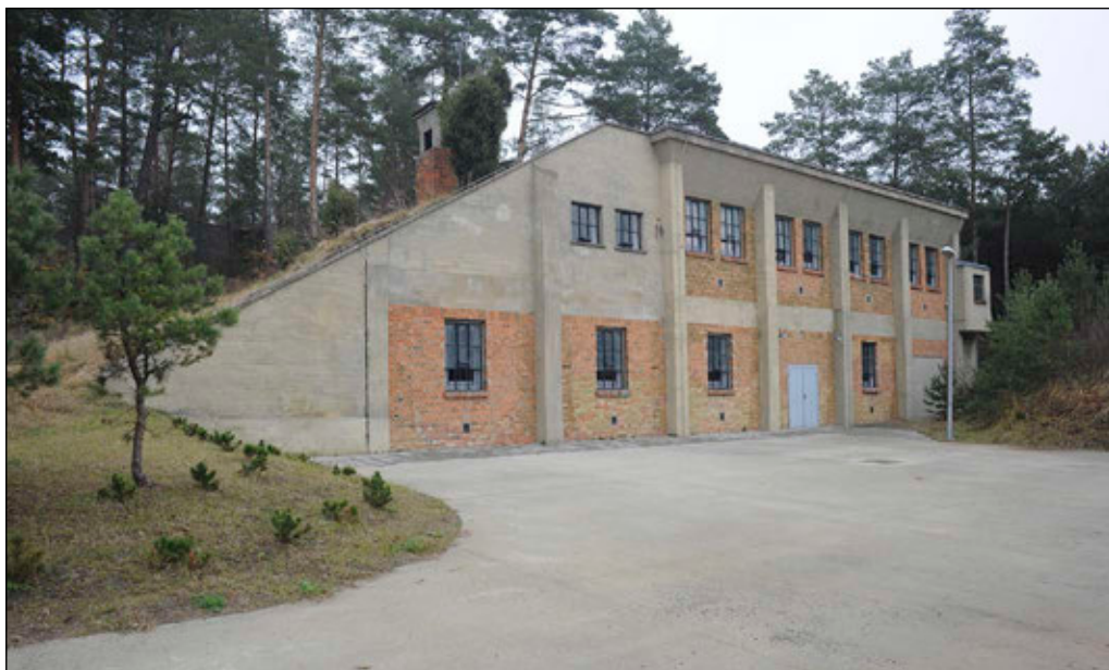
3. Budynek 1133 – Przygotowanie produkcji
