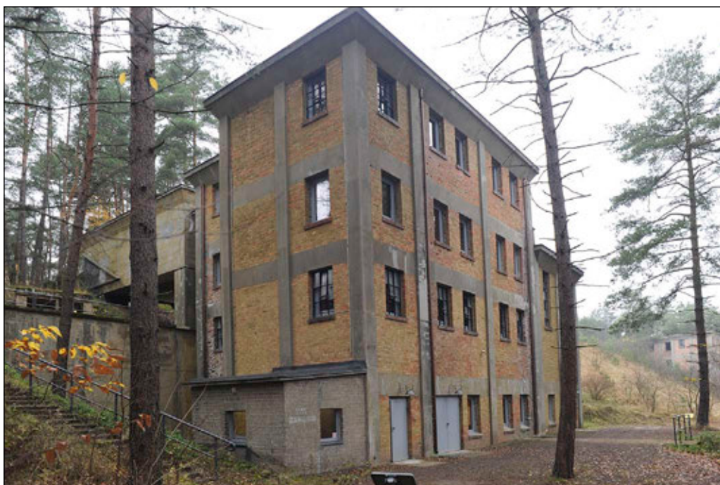
6. Budynek 1115 – Budynek denitracji kwasów
